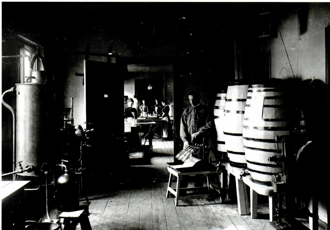
Meyer Zadig rekryterades från Hamburg som verkmästare till Hanson & Sewans tvålfabrik 1863. Bara några år senare startade Zadig tillsammans med sönerna sin egen tvålfabrik. 1871 köpte man tomten vid Stora Nygatan 63 och byggde där fabrik och bostad. I tvålfabriken tillverkade man tvål, parfym, bläck m.m. På denna odaterade bild från fabriken ser man hur personalen tappar upp olika vätskor i flaskor.
