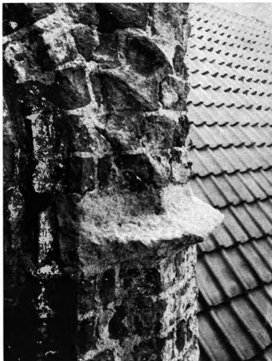
Fig. 71. Tegel, hugget i spiralvridning. Hörnhusets norra gavel.
