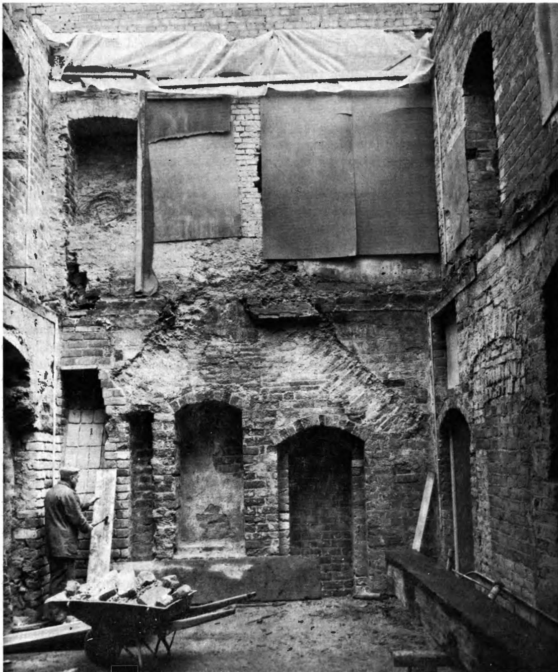
Fig. 52. Stortorgslängans södra gavel efter friläggande. Målningsfragmenten döljes under plast och träskivor.
