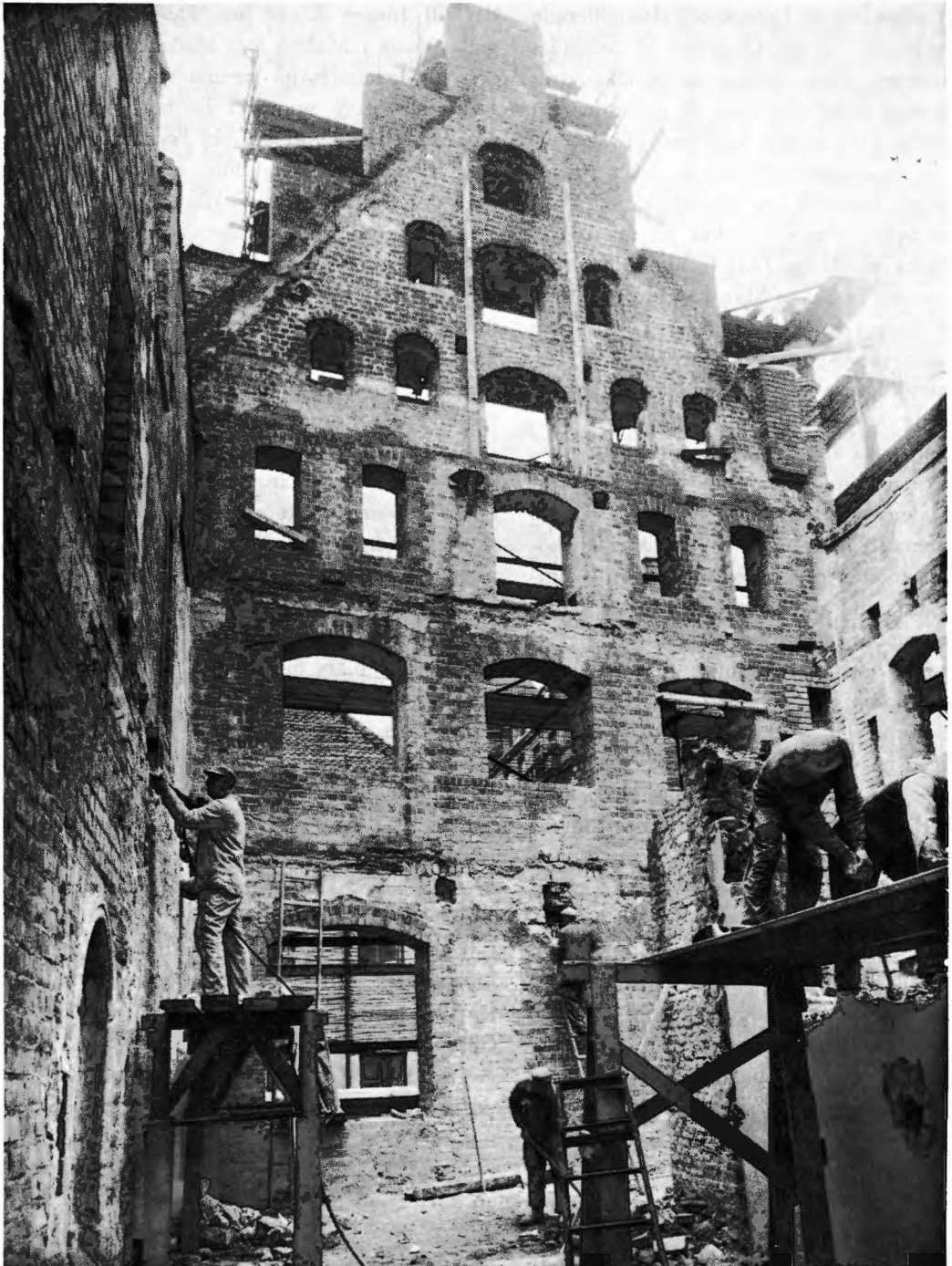
Fig. 33. Hörnhusets norra gavel sedd från insidan efter friläggning.
