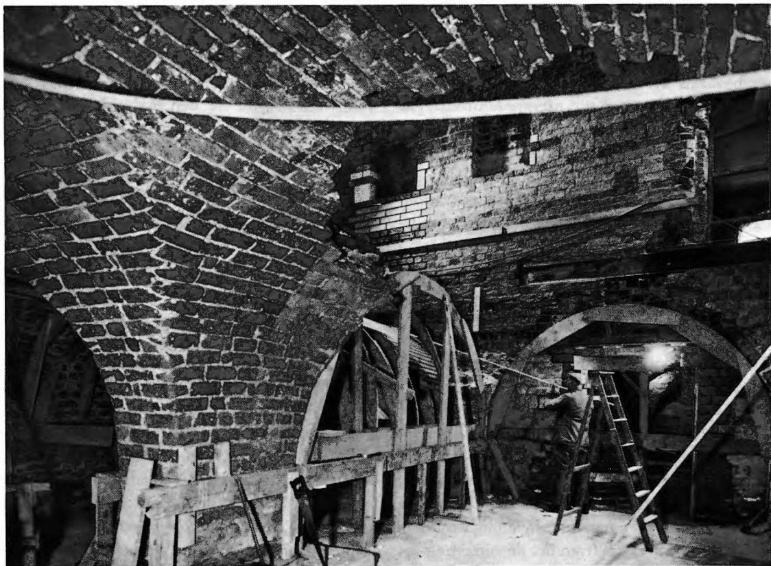
Fig. 48. Den år 1878 upphuggna öppningen i västergatslängans källarvalv. I bakgrunden hörnhusets västra mur, jfr med fig. 45.
