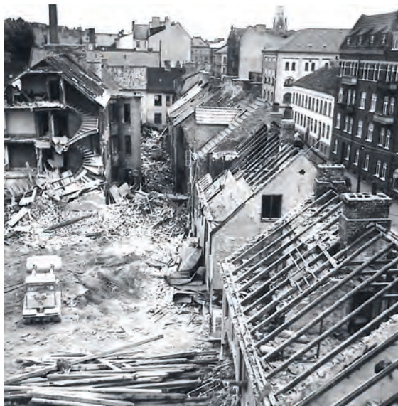
Fig. 56. Rivningen är i full gång i kvarteret Rostock på 1960-talet. Hela kvarterets 66 byggnader, uppförda 1857–1921, försvann vid rivandet. Kvarteret ingick i den så kallade "Nya staden", som började bebyggas i början av 1800-talet. – Bild: Malmö Stadsarkiv bildsamling.
