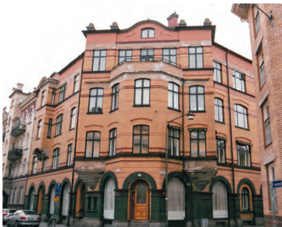
Fig. 26. Hörnhuset vid Västergatan och Långgårdsgatan i kv. Gråbröder, uppfördes 1901 av byggmästare Per Nilsson Dahlgren. Här låg tidigare det gamla kronobarnhuset från slutet av 1600-talet, och som sedermera blev fattigvårds- och arbetsinrättning. Barnhustomten upptog nästan hela västra delen av kvarteret. Det var här som Malmös första stadsarkivarie Anders Ulrik Isbergs farfar Jonas Isberg bedrev skolundervisning för de fattiga barnen. Fattigvårdsinrättningen upphörde med sin verksamhet här på 1890-talet och flyttade inrättningen till området vid Värnhems sjukhus. – Foto: Staffan Gudmundsson.
