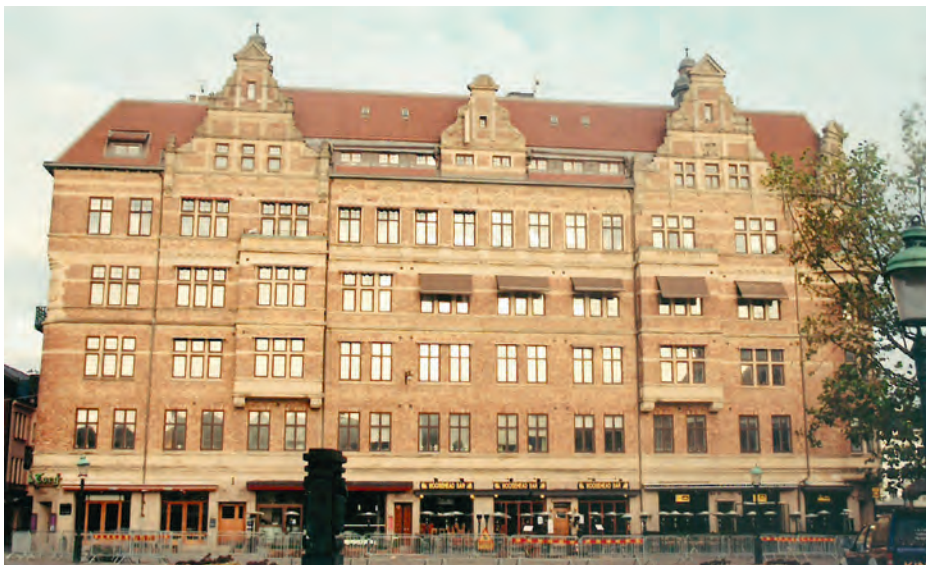
Fig. 12. Det var på denna tomt vid Lilla Torg och Stortorget, där den ståtliga byggnaden står, och som är ritad av arkitekt Oscar Hägg 1911, som gårdarna ödelades vid branden 1724. – Foto: Staffan Gudmundsson.
