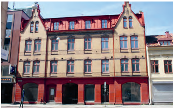
Fig. 54. Fyravånings bostadshus vid Djäknegatan i kv. von Conow. Uppfördes 1899 av byggmästare Johan Theodor Billberg.
