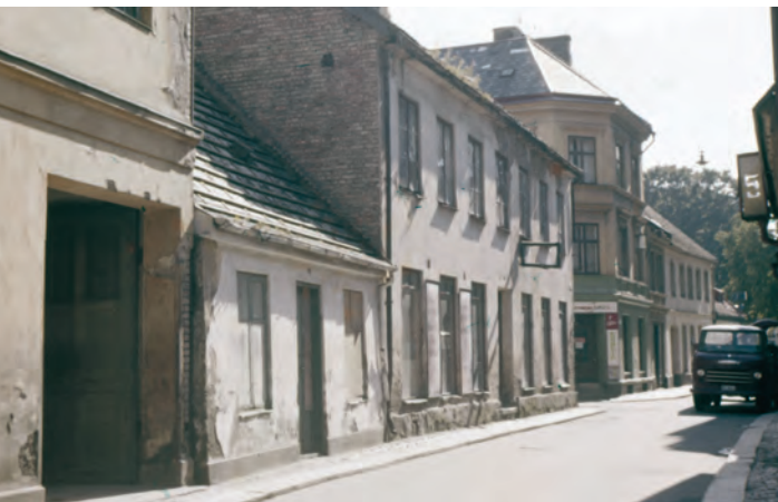
Fig. 60. Kattsundsgatan på 1960-talet, innan rivningen. Husen på vänster sida i bild är uppförda på 1800-talet. Snart skall denna gamla bebyggelse lämna plats åt det moderna 6-våningshuset som ingick i "Carolikomplexet". Se bilden ovan. Tar man till vänster vid trevåningshuset på hörnan, som är uppfört 1886, kommer man till Jerusalemsgatan. Vid det stora kastanjeträdet i fonden, där det idag är en lekplats, går Rundelsgatan. – Bild: Malmö Stadsarkivs bildsamling.
