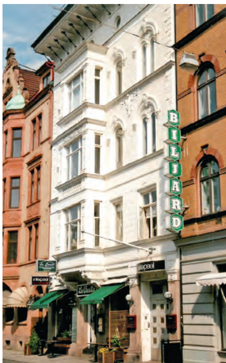
Fig. 42. Fyravånings bostadshus vid Stora Nygatan i kv. Ellenbogen. Uppfördes 1898 av byggmästare Frans Andersson. – Foto: Staffan Gudmundsson.
