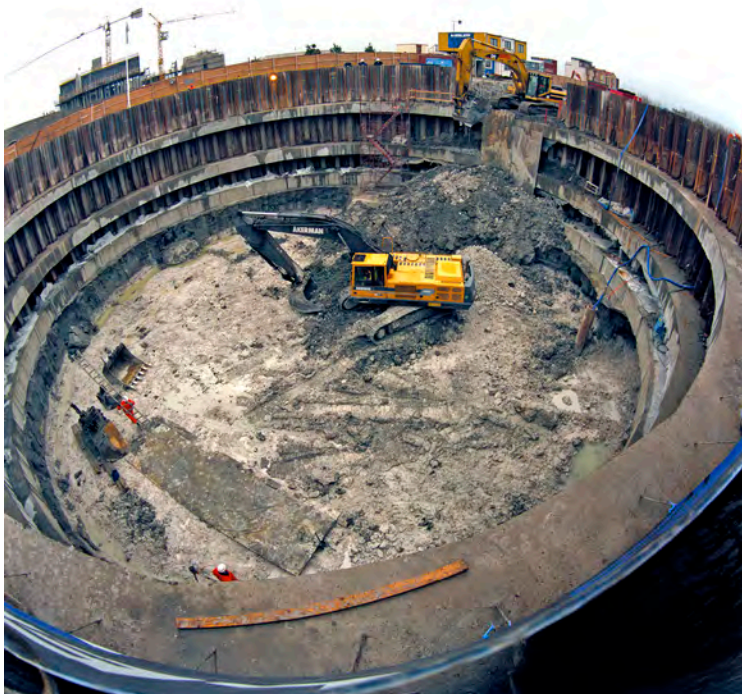
Fig. 35. 2001 Turning Torso växte upp ur detta fundament som var sju meter tjockt. Det krävdes 6000 kubikmeter betong för att gjuta grunden. Arkitekt Santiago Calatravas skapelse växte upp och blev en ny siluett i Malmö. Pierre Mens följde projektet på nära håll och berättade tillsammans med författaren Björn Ranelid i boken "Turning Torso" om det fantastiska huset vid Öresund.
