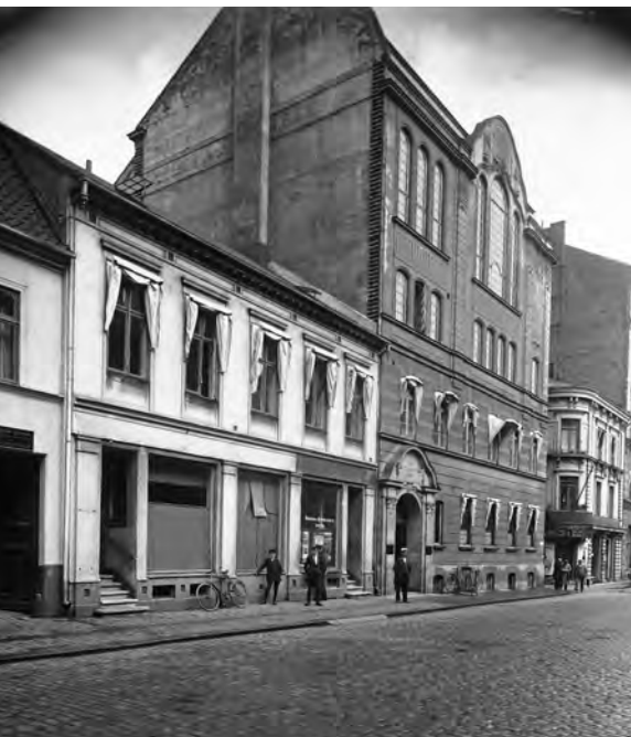
Fig. 3. Televerkets centralstation på Adelgatan 9 i Malmö. Fotot taget efter det att huset byggts om 1908. – Foto: Carl Wilhelm/Malmö Museer.
