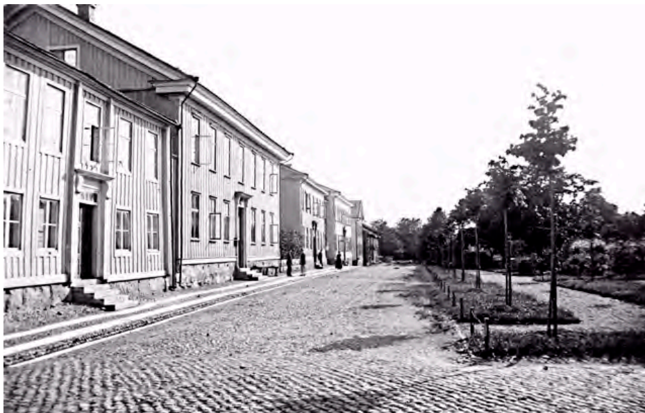
Fig. 1. Teklas familj bodde i andra huset från vänster. Fadern hade uppfört det på 1840-talet, idag är det byggnadsminne. – Foto: Hedvig Högdahl. Ingår i Åmålsortens Hembygdsförenings samlingar.
