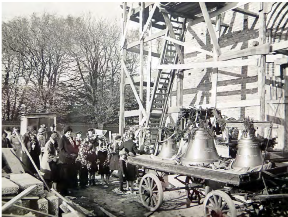
Fig. 8. Här anländer kyrkklockorna för montering i tornet (DEG).
