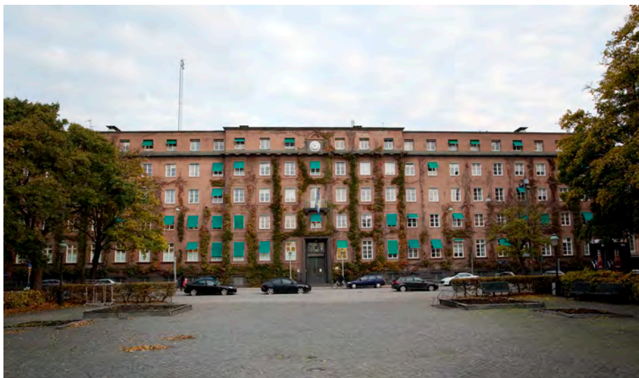
Fig. 4. Det gamla häktet på Davidshall kommer inom en snar framtid att vara unika bostadsrätter. Borta är de trånga cellerna och tunga häktesdörrarna. Men föremål och berättelser om människorna som hamnade på häktet och om dem som arbetade där, finns fortsatt bevarade på Malmö Museer, genom vårt insamlings- och dokumentationsarbete. – Foto: Johanna Rylander / Malmö Museer
