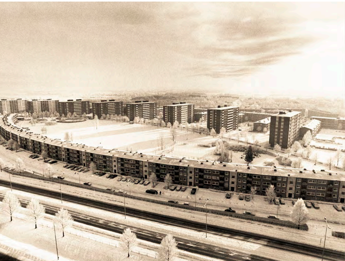
Fig. 9. Segevång fotograferat en snöfrostig vinterdag från dåvarande Sydsvenskan-skrapan. Närmast kameran skimtar Stockholmsvägen och därefter Lundavägen. Den bågformade huskroppen i kvarter Ögonfransen löper längs med Segevångsgatan. Byggnaden, som utgör två skilda fastigheter, är ett suterränghus i gult tegel och är nästan 500 meter lång. Den västra delen (till höger), Ögonfransen 1, ritades av Thorsten Roos och Bror Thornberg för MKB 1959. Den östra delen, (till vänster), Ögonfransen 2, ritades av Sven Grönqvist på HSB:s arkitektkontor 1959. Ögonformen är grundtemat i områdets struktur. Parken är utformad av Walter Kohl 1960. Bakom denna reser sig höga skivhus längs med Kronetorpsgatan i kvarteret Ögonlocket. Dessa byggnader ritades 1959 av Sven Grönqvist på HSB:s arkitektkontor, liksom en stor del av de övriga byggnaderna i kvarteret. – Foto: Ur Fastighetskontoret i Malmös arkiv, bild nr 27671 i bildarkivet.
