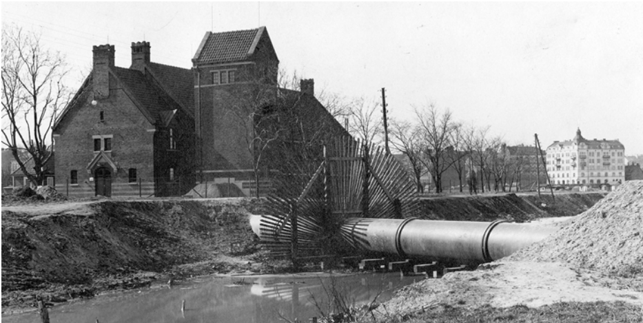
Fig. 9. Rosendal byggdes för att pumpa ut Malmös kloakvatten i Öresund. ”Stadsarkitekten Salomon Sörensen, lyckades i formgestaltningen ge en sakral anstrykning på avloppshelgedomen”, skriver ingenjör Eber Ohlsson i VA-Syds skrift om pumpstationen. – Foto: Malmö stads byggnadskontor.
