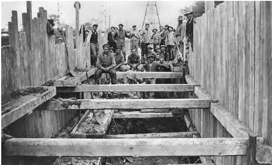
Fig. 7. Kloaken går under jorden – tidigt 1900-tal byggs Malmö första täckta avlopps nät efter 30 år av planering. – Foto: Malmö stads byggnadskontor.
