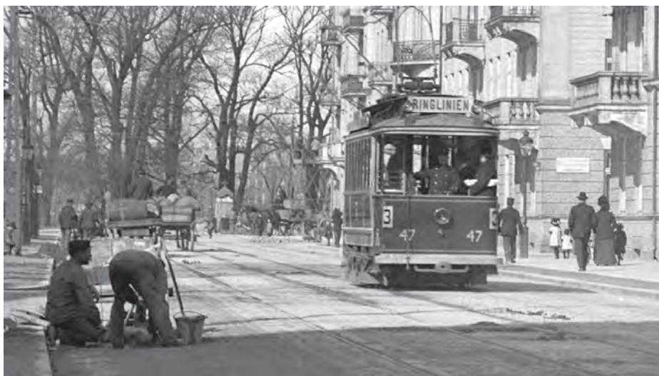
Fig. 7 a, b. Glasnegativ från Rönneholmsvägen västerut med Jörgen Ankersgatan till höger. På den undre detaljbilden syns en spårvagn och ett gatuarbete. Mitt i bilden syns en speciell hästdragen vagn med ett högt torn på. Den användes i samband med uppsättandet av kontaktledningar till spårvägen. Här är det den tillfälliga linje X1 från Centralen över Fersens väg till Baltiska utställningen som färdigställdes våren 1914.
