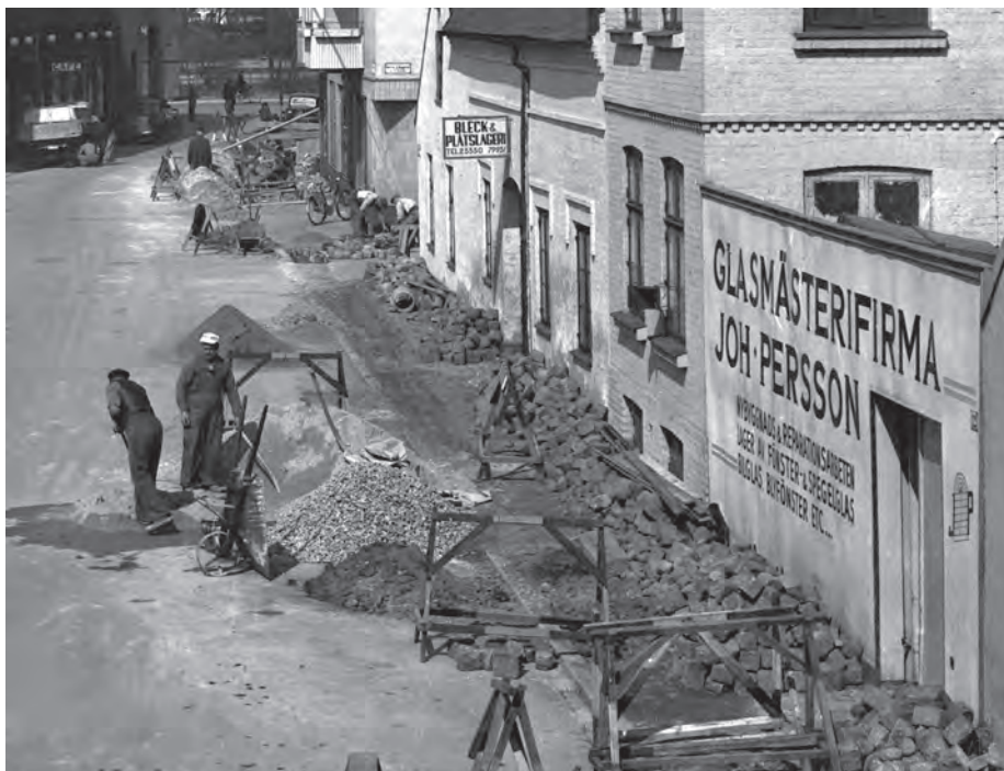
Fig. 8. Glasnegativet från artikels inledning i förstoring. Västra Kanalgatan från Storgatan. Det pågår gatuarbeten, men utan maskiner, bara hårt manuellt arbete. Glasmästerifirman Joh. Persson ligger idag på Vattenverksvägen och har varit verksam i 140 år.
