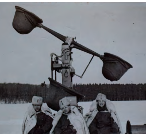
Fig. 6 a & b. Lyssnarapparat VD3 m/36 i olika positioner.
