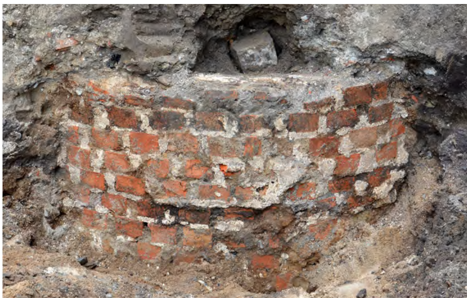
Fig. 10. Tegelbrunnen som framkom när schaktväggen rasade. Ovanpå ett trälock låg en storgatsten vilket visar att brunnen har varit framme i sen tid. – Foto: Per Sarnäs.
