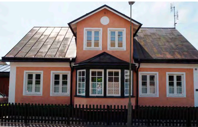
Fig. 8. Det rosa huset på Carl Johansgatan 49, varsamt återställt.
