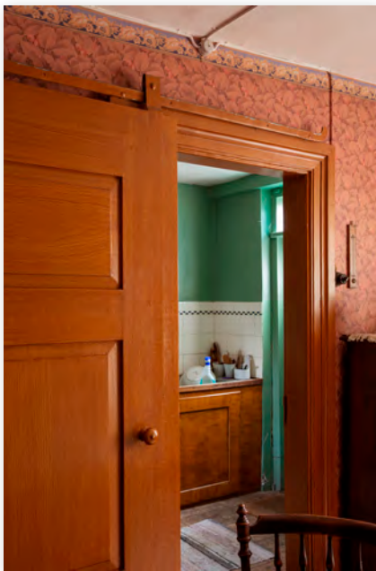
Fig. 12. Olofs ådringsmålade skjutsdörr mot köket och nydragna kuloledningar. – Foto: Andreas Nilsson, Malmö Museer.
